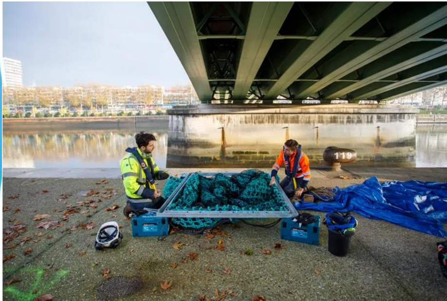
La pose de ces filets a coûté 150 000 euros. - Alan Aubry - Métropole Rouen Normandie
